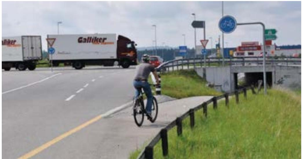
Abbildung 48: Niveaufreie Querung bei nicht veloverträglichem, zweistreifigem Kreisverkehr
