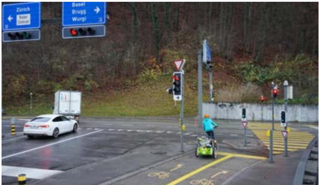
Abbildung 46: Durch seitliche Anordnung ist keine Verflechtung notwendig
